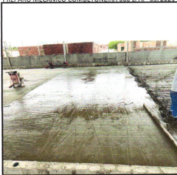
FOTO-14 CONCRETO FCK = 15MPA, TRAÇO 1:3,4:3,5 (EM MASSA SECA DE CIMENTO/ AREIA MÉDIA/ BRITA 1) - PREPARO MECÂNICO COMBETONEIRA 600 L. AF_05/2021
