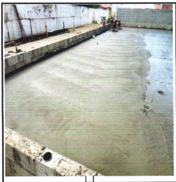
FOTO-13 Polimento de piso cimentado - R1
