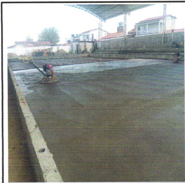
FOTO 16-Polimento de piso cimentado - R1
